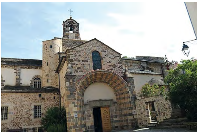
Eglise Saint-Pierre de Blesle
